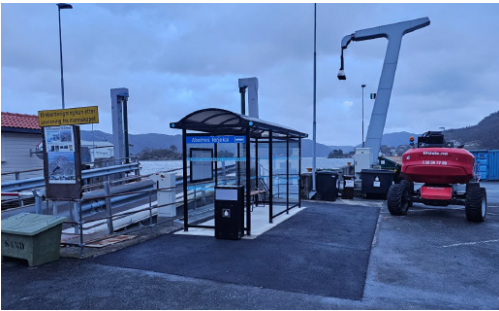
Det ble satt opp nytt lehus på Abelnnes ferjekai.
